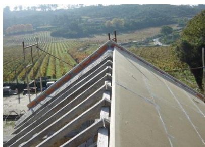
Fig. 42 – Remate das juntas com mástique
