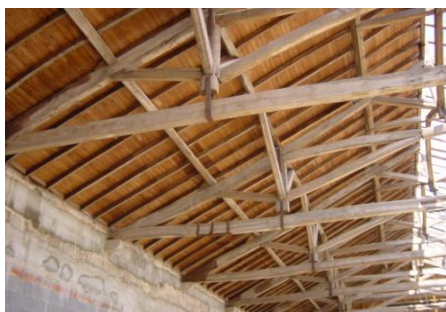
Fig. 36 – Ondutherm sobre estrutura existente
