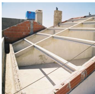
Fig. 39 – Aplicação de painel sobre estrutura de betão
