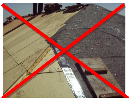
Fig. 45 – Aplicação de tela asfáltica colada por cima de painel Ondutherm
