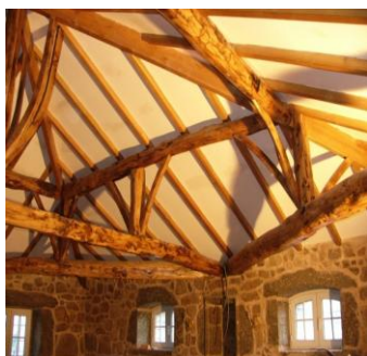
Fig. 38 – Aplicação de painel sobre estrutura de madeira
