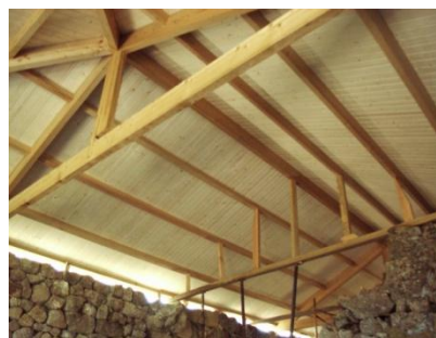
Fig. 37 – Ondutherm sobre estrutura nova
