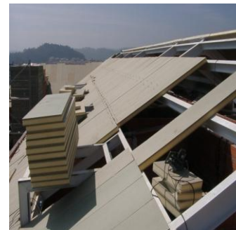
Fig. 40 – Aplicação de painel sobre estrutura metálica
