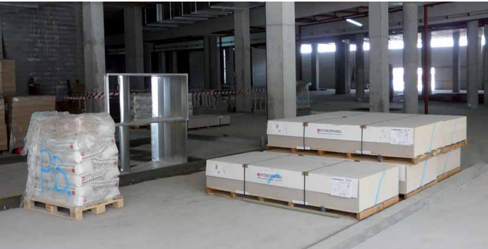
Zona de acopio Centro comercial Marineda City, A Coruña (Galicia)
