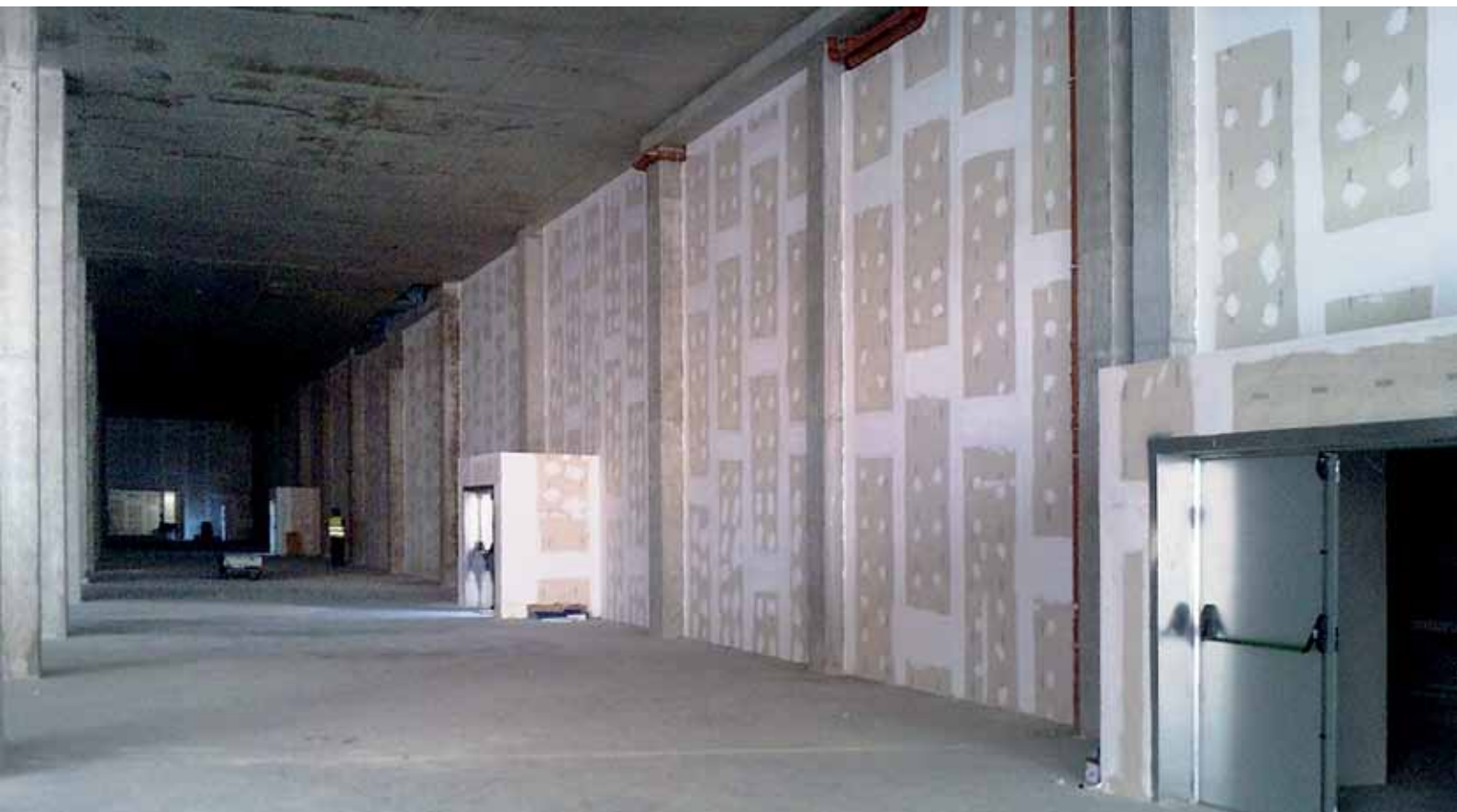
Obra Centro comercial Marineda City, A Coruña (Galicia)
