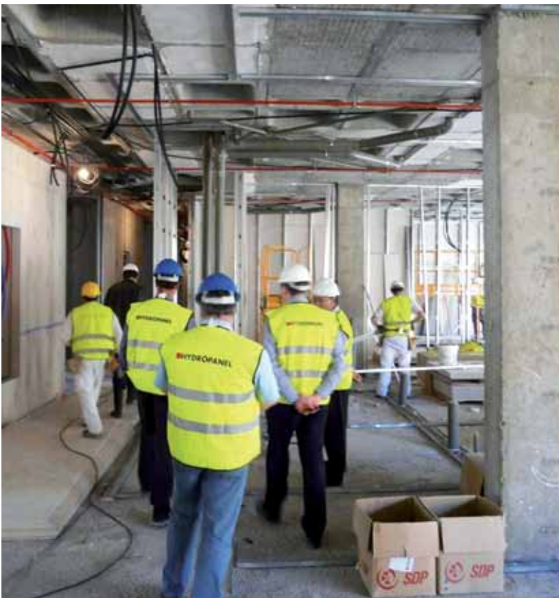
Obra Gran Hotel Conil, Conil de la frontera (Cádiz)
