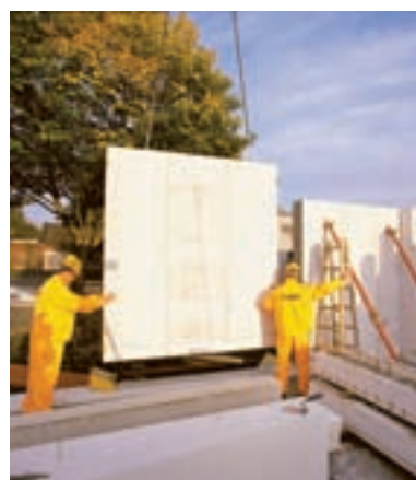
Paredes Ytong pré-fabricadas.
